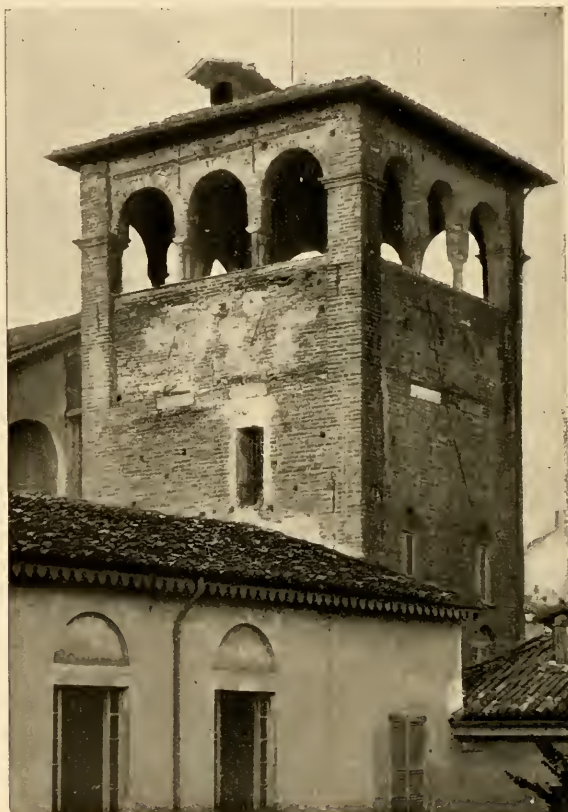
Fig. 355 — Torre del Monastero Maggiore a Milano (a. 868-881)
